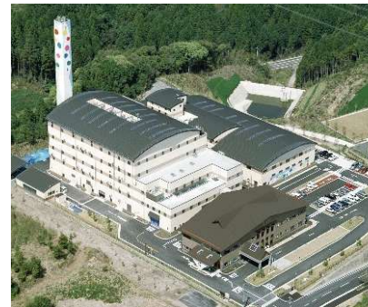
ごみ焼却・溶融プラント
