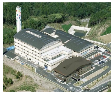
ごみ焼却・溶融プラント
