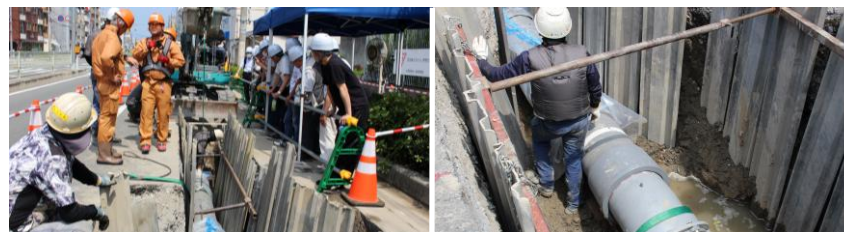
(管路更新の様子)
