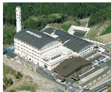
ごみ焼却・溶融プラント
