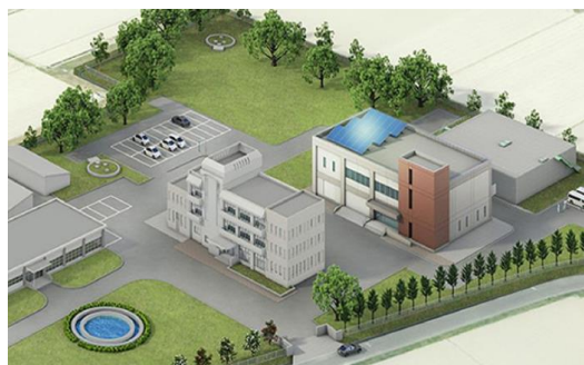
備前市(坂根浄水場)
