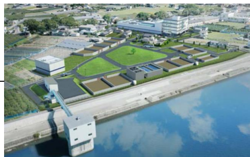
鳴門市・北島町共同浄水場
