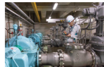
浄水場点検のようす
