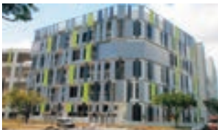
精米設備を設置した食品加工団地のビル
