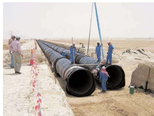
●中東に敷設中のダクタイル鋳鉄管
