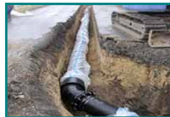
被災地での耐震水道管の敷設状況
