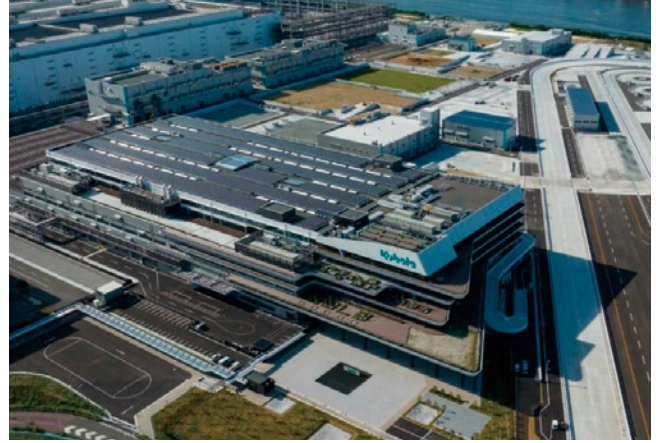
クボタグローバル技術研究所では出力1,566kWの太陽光パネルを設置
