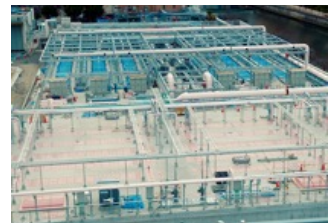
中浜下水処理場では、膜分離活性汚泥処理(MBR)による排水処理が行われています。
