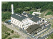
●ごみ焼却・溶融プラント
