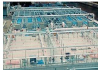
中浜下水処理場では、膜分離活性汚泥処理(MBR)による排水処理が行われています。
