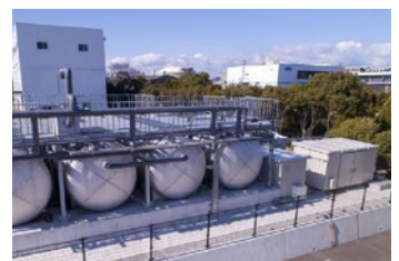
クボタ堺臨海工場 液中膜方式のFRP浄化槽
