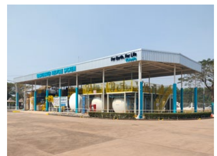
Kubota Engine (Thailand) Co., Ltd.では、膜分離活性汚泥法(MBR)による排水処理システムを増設し、排水を場内散水や生活用水に再利用しています。
