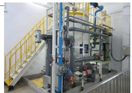
久保田農業機械(蘇州)有限公司(中国)では、工場全体の工程排水を再利用する再生処理装置を導入し、工程排水排出口を実現しています。
