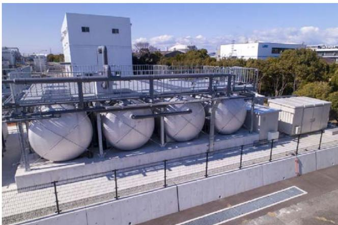
クボタ堺臨海工場では、液中膜方式のFRP浄化槽を増設しました。生活系廃水の高度処理が可能で、1日当たり最大110m<sup>3</sup>の排水を処理することができます。また、BCP対策として、排水処理施設のコンクリート基礎の嵩上げを行いました。IoTを活用した水管理ソリューションシステム「KSIS」を導入し、工場排水の適切な管理を実現しています。
