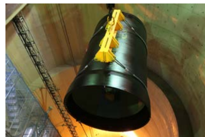
耐震型ダクタイル鉄管 呼び径1500~2600 US形(R方式)
