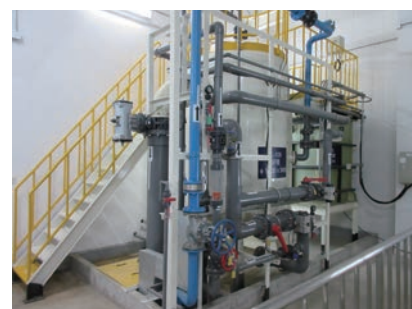
久保田農業機械(蘇州)有限公司(中国)では、工場全体の工程排水を再利用する再生処理装置を導入し、工程排水排出ゼロを実現しています。2020年は約14万 \text{m}^3 の水使用量を削減しました。
