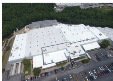
第一工場へ設置（2019年）
