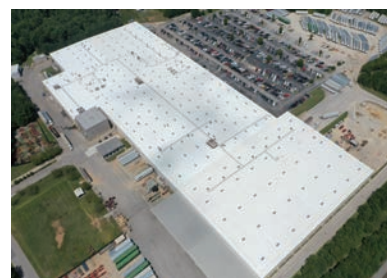
第二工場へ設置（2020年）
