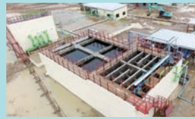
ティラワ工業団地に施工した浄水場
