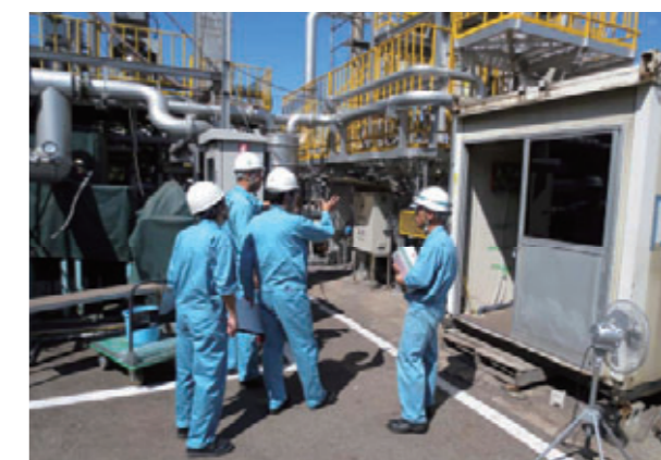
国内拠点監査 (新田川環境プラントセンター)
