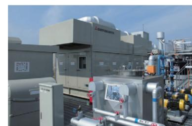
堺製造所：自家発電時に生じた排熱を利用し、蒸気ボイラー燃料を削減。
