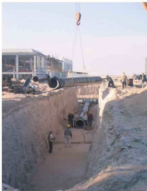
●クワートで敷設中のダクタイル鉄管
