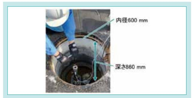
図 9 センサメンテナンス試験状況
