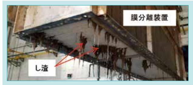
図2 し渣付着状況(膜分離装置下部)
