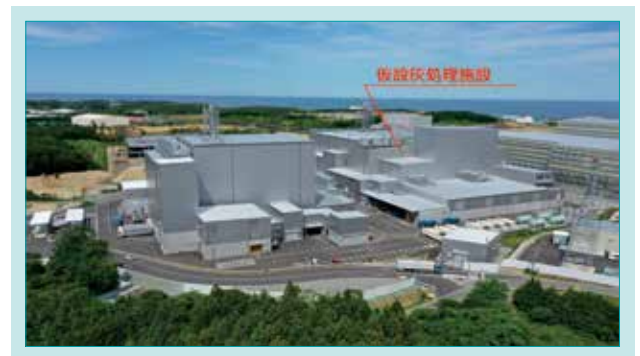
図2 仮設処理施設の全景
