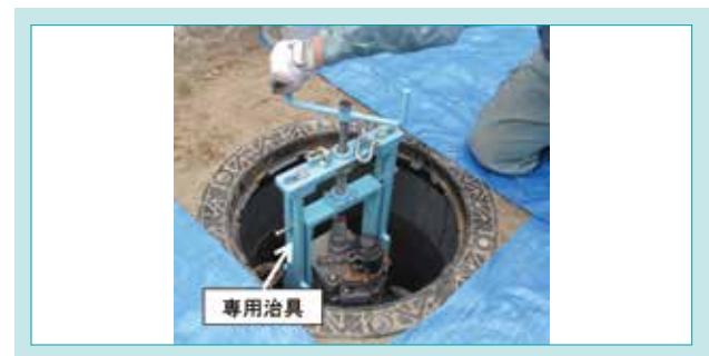
図 12 専用治具の使用例 Fig. 12 Example of Specialized Tool
