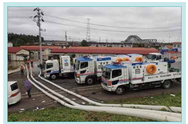
図1 ポンプ車出動状況(国土交通省写真提供) Fig. 1 Drainage Pump Vehicles Operating Photo
