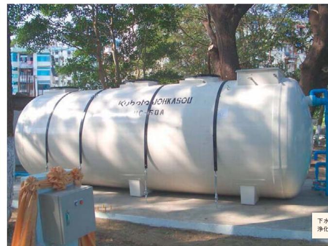
下水道のない地域では、浄化槽が排水の浄化処理を担う。
