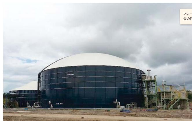
マレーシアで稼働する処理設備の全景。中央の巨大な槽でバイオガスを発生させる。
