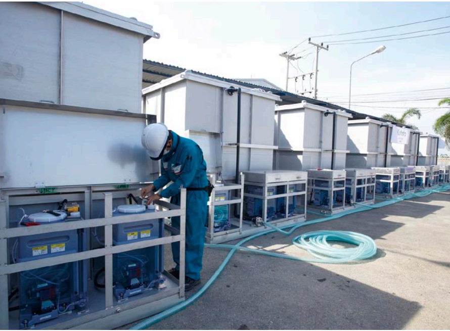
ユニット型の発電機付浄水設備（フィルセラ）
