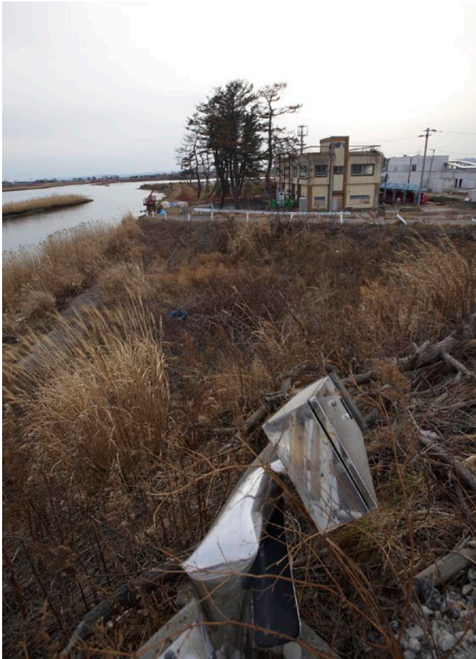
津波の被害を受けた排水機場。 現在は修復し稼働している(宮城県名取市)
