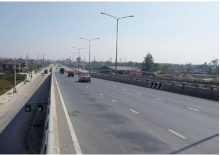
幹線道路は洪水からの堤防の役目も担う。 現在のキングスダイクは、整備された道路と河川の堤防で 構成される(ノムタムニ県ラックホック近郊)
