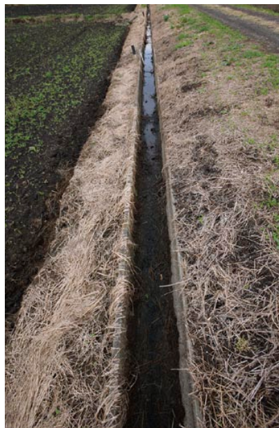
クボタからの提案は、用水路は使用せずに、雨水での除塩試験だった(2011.10.17撮影)
