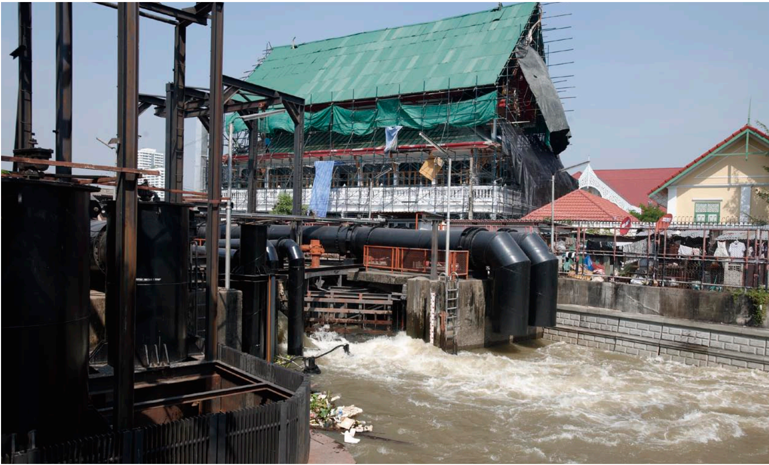
チャオプラヤ川から大量の水を引き込む水門。幾重もの水路がバンコク都内に張り巡らされている
