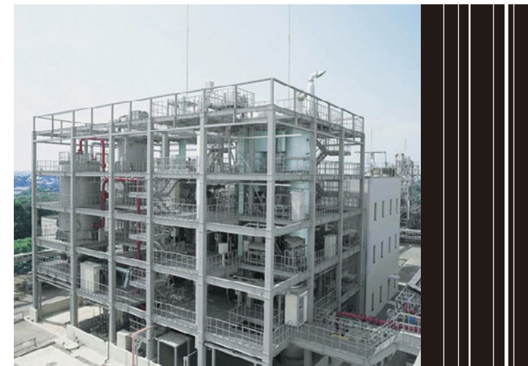
循環流動焼却炉が導入された2号焼却炉(外観)
