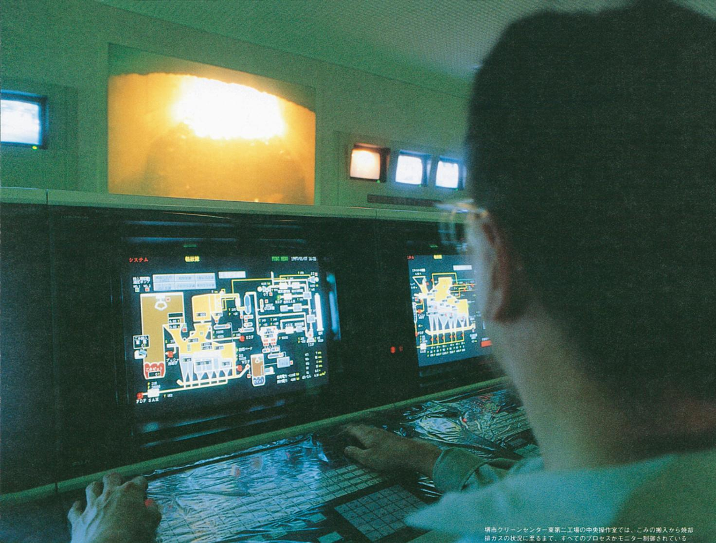
堺市クリーンセンター東第二工場の中央操作室では、ごみの搬入から焼却排ガスの状況に至るまで、すべてのプロセスをモニター制御されている
