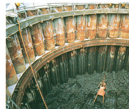
クボタ鋼管矢板を用いた、鋼管矢板基礎工法——矢板を連結し止水壁をつくる(写真は東京湾横断道路のものではない)
