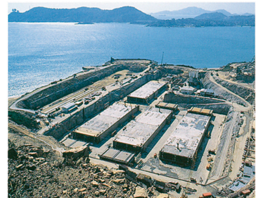
セッコー（石澳）の面体製作ヤードで建造が進む巨大な沈埋面（一体が8.6×33.4×113m、33,000トン）——この面体12本が海底で連結され、香港島と九龍半島を結ぶ新たな海底トンネルとして新空港へのアクセスの要となる（注3）
