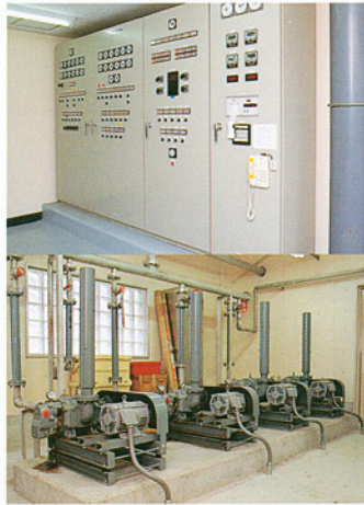
管理室内制御盤(上)とフロア室内ポンプ(下)——田所処理場にて
