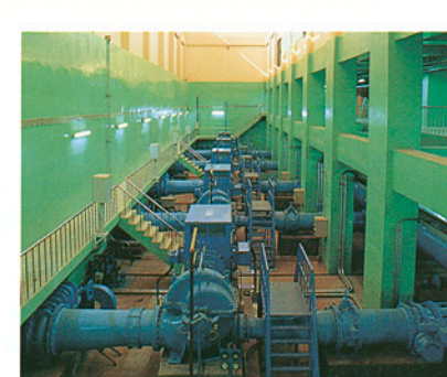
プアラン浄水場に設置された5台のクボタ製ポンプ(両吸い込み渦巻きポンプ)——営業運転を目前に控えている
