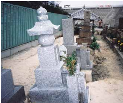
多くの墓石は転倒寸前で立っている(西宮市上田墓地) (写真5-2,5-3:千葉県地質環境研究室)
