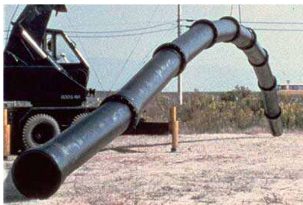
耐震継手ダクタイル鉄管の吊り上げテスト
