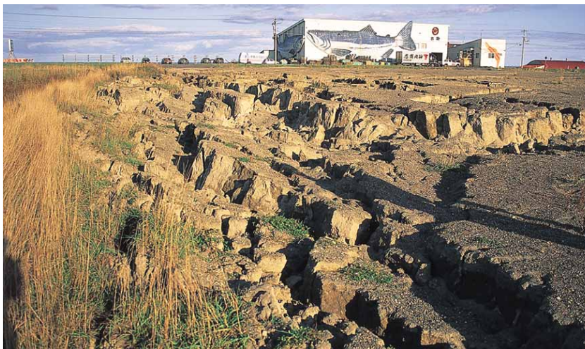
写真3・3—粗粒火山灰盛土層の地すべり状の崩壊(別海町)
