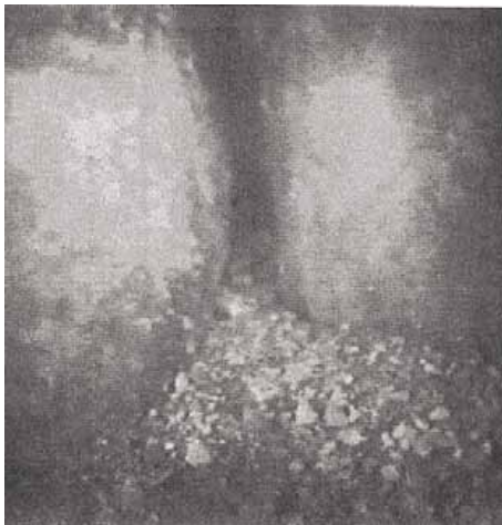
写真5・1-ケーソン継ぎ目から海底に流出する砂礫(水深約10m/水中カメラ撮影)
