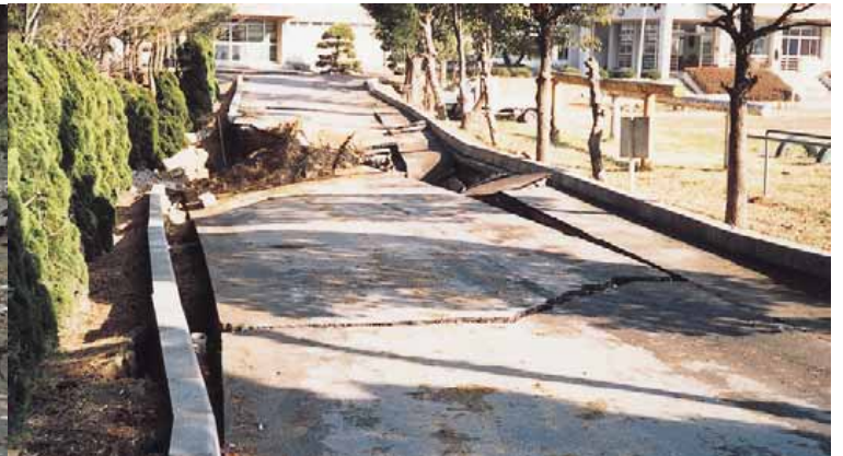
写真2・6-法面上端部の陥没
