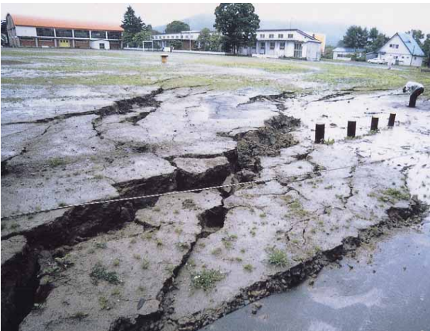
写真3・1-クルミ坂岩屑なだれ堆積物に発生した陥没
