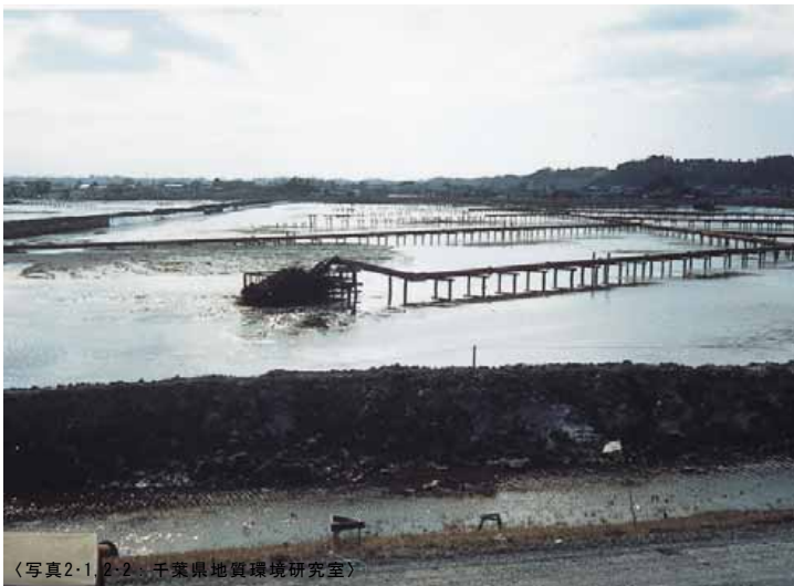
写真2-1ーサンドポンプ工法による埋立(利根川下流低地)
