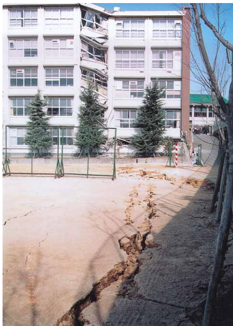
写真4・1―特別教室棟東端部の破壊とグラウンドに生じた亀裂
