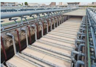
液中膜ユニット 生活排水や産業排水など下水を浄化します。
