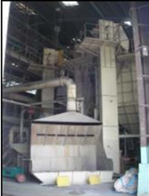
尼崎(異形管砂再生)
