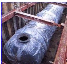
耐震・緊急用貯水槽
