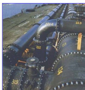
異形管を用いた配管風景
