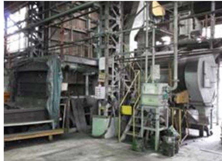
尼崎(ロール砂再生)
