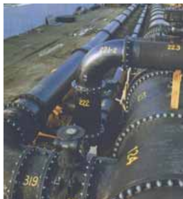
異形管を用いた配管風景
