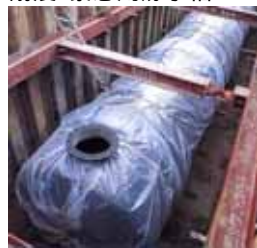
耐震・緊急用貯水槽
