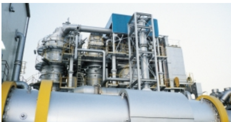
ガス化溶融炉
