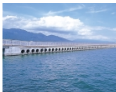
クボタパイプ式消波透水堤
