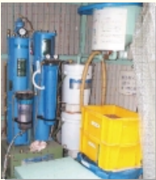
油水分離装置
