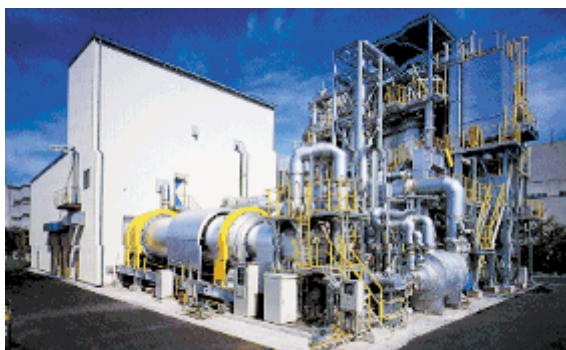
ガス化溶融炉
