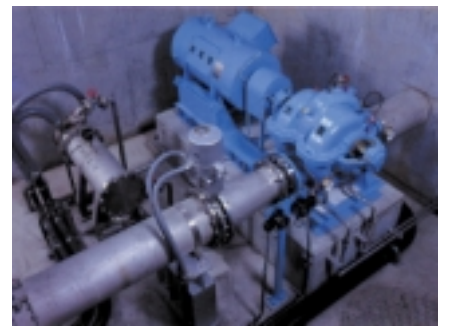
ポンプ逆転水車
