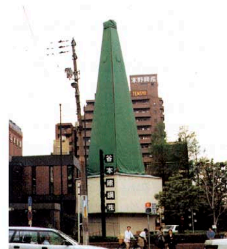
騒音と危険の防止のため、ボーリングの機には緑のカバーが かけられ、ボーリング・マシン本体は仮設小屋の中に設置さ れている。〈特殊プラント工業提供〉
