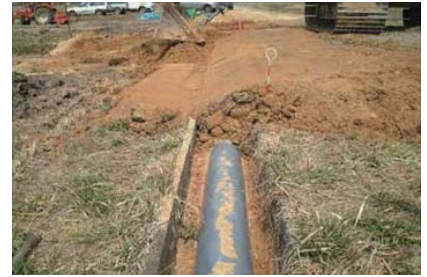
開水路に埋設したパイプ
