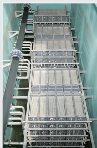
土木水槽設置タイプのクボタ フィルセラ®フローシート
