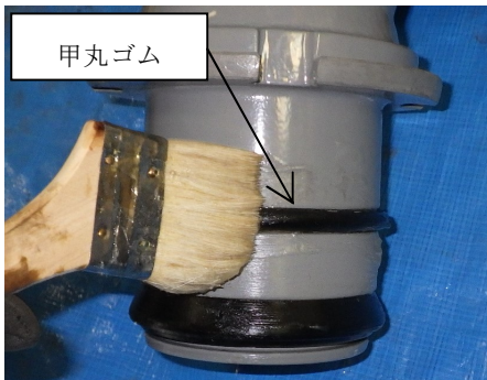
図6 補修弁挿し口への滑剤塗布
