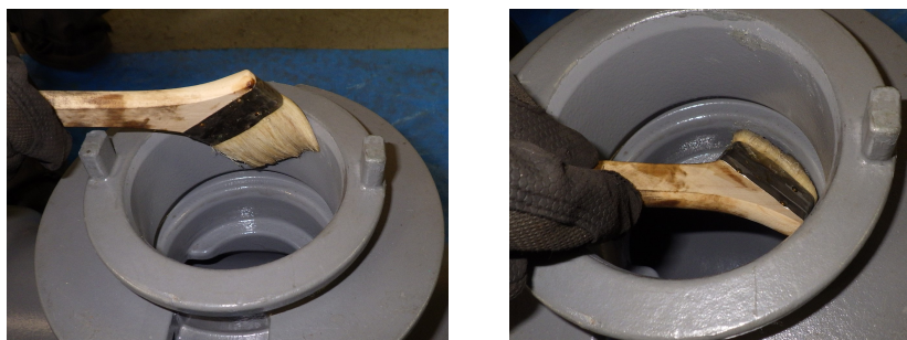
図4 T字管受口への滑剤塗布
