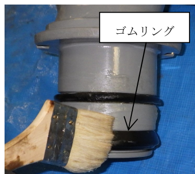
図6 補修弁挿し口への滑剤塗布
