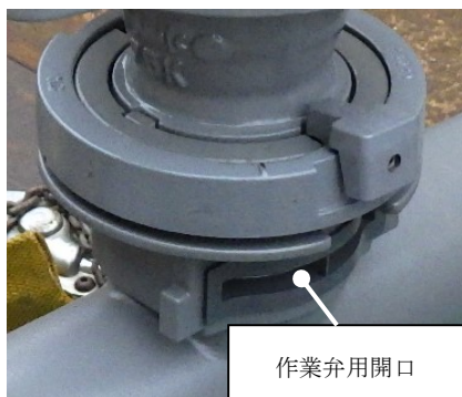
図30 作業弁用開口
