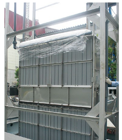
液中膜ユニットの据付
