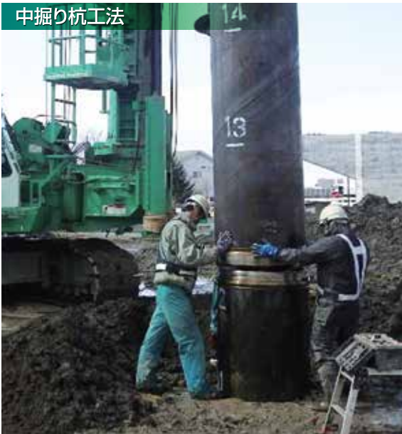
油圧式全回転中掘り工法
