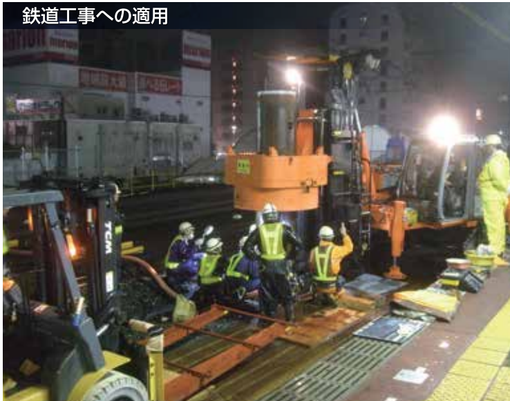
鋼管矢板基礎への適用
