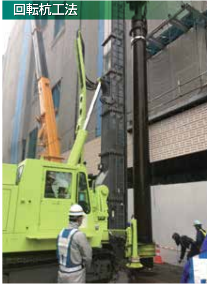
油圧式全回転中掘り工法
