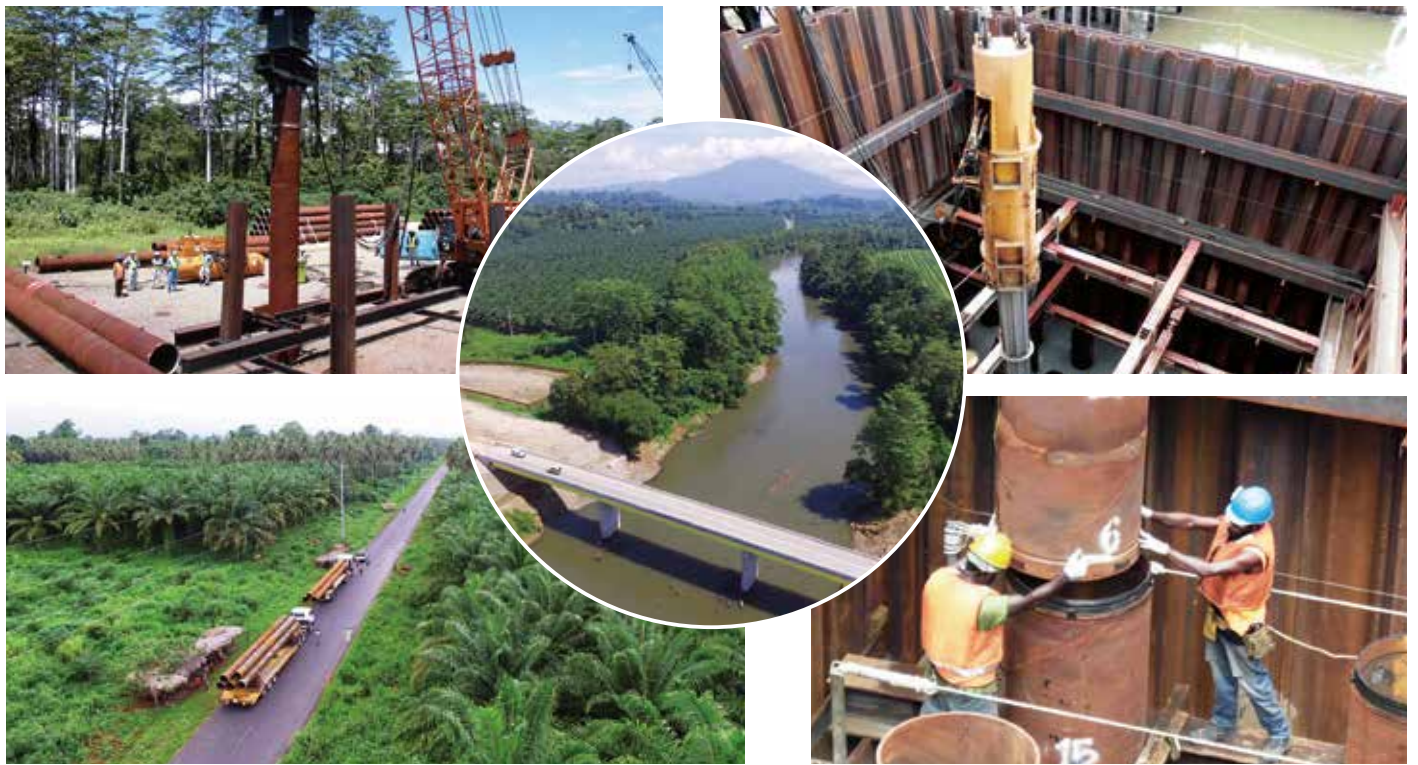
※ ニューブリテン国道橋梁架け替え工事 / パプアニューギニア独立国
