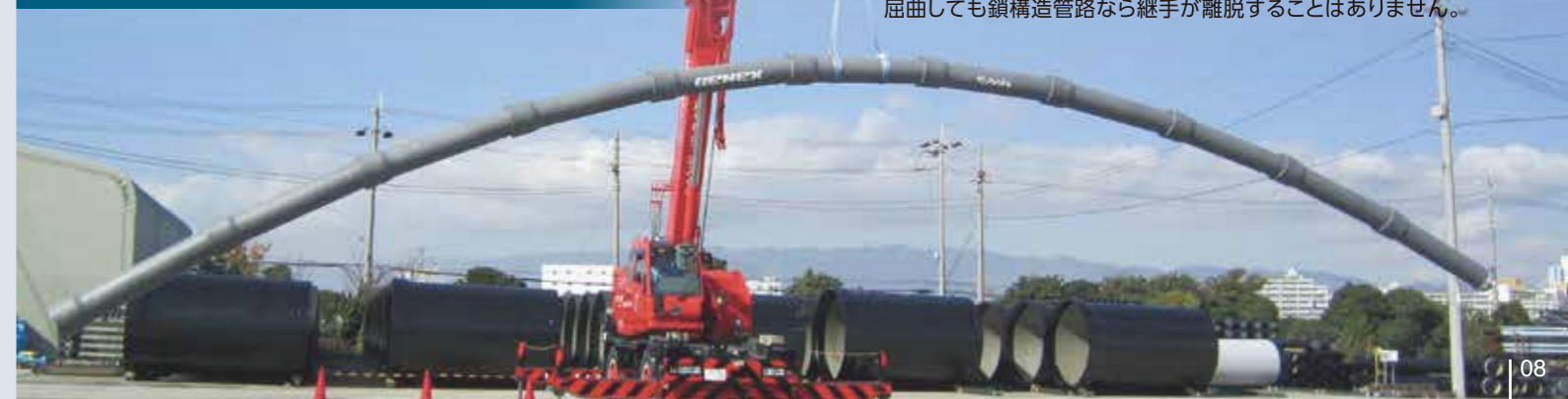
GENEX呼び径300を11本繋いで吊上げた状態
