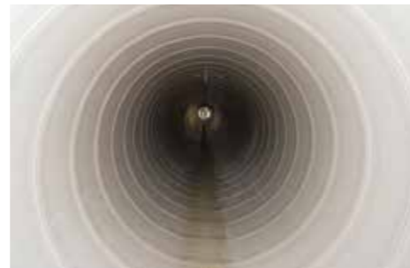
施工後の内面の状況
