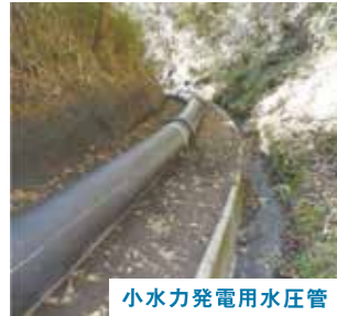
急傾斜地での施工例。
