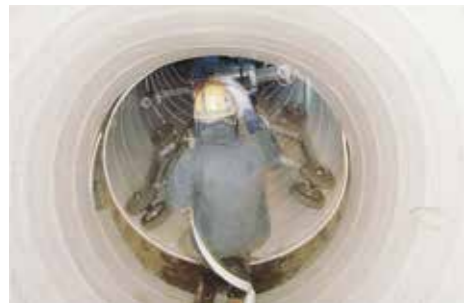
サイホン屈曲部の施工状況
