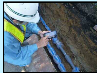
〈施工現場での様子〉
