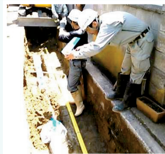
継手を撮影中 (施工情報システムで撮影しています。)
