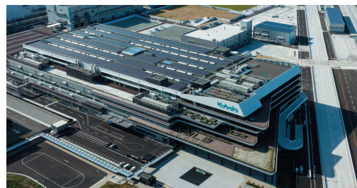
グローバル技術研究所に出力1566kWのソーラーパネルを設置（大阪）
