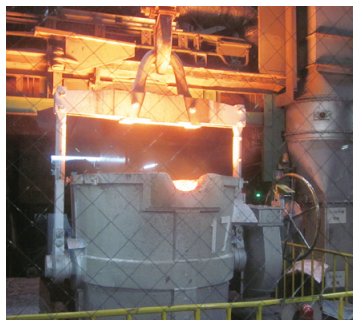
鋳物製造で使用する溶解炉を電気炉化
