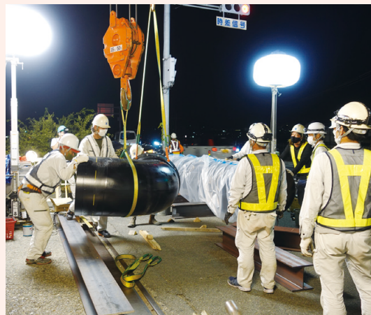
水道管の仮復旧を迅速にサポート
