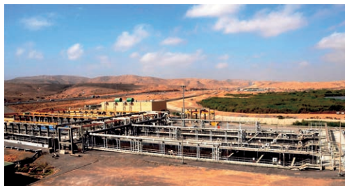
オマーン国の下水処理場で採用される高度処理用液中膜
