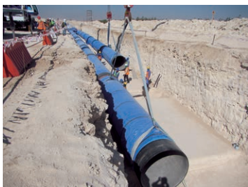
カタールで布設されるダクトイル鉄管
